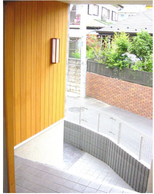
改修 後 共用部
