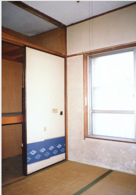
改修前 住戸内
