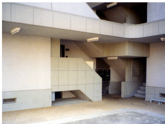
改修後 共用部
