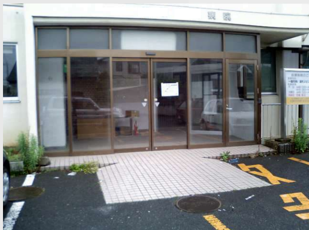
改修前 エントランス
