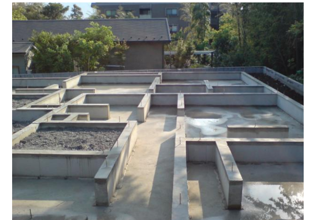
コンクリート打設後の状況
