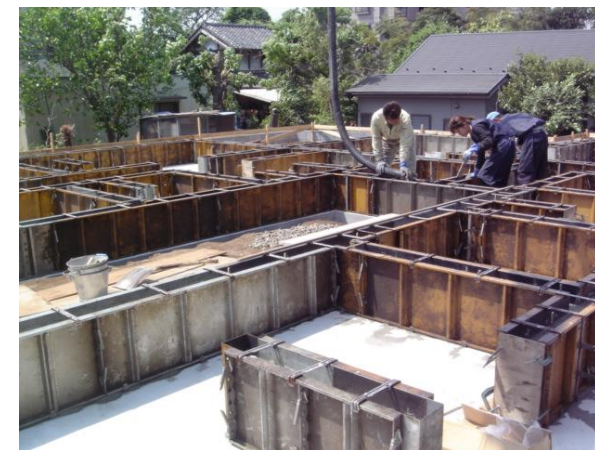
耐圧版の上に基礎立ち上りのコンクリートを打設
